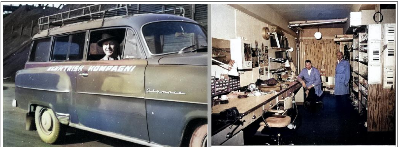
Alf arbeidet i «Elektrisk Compagni» (til høyre i høyre bilde).
